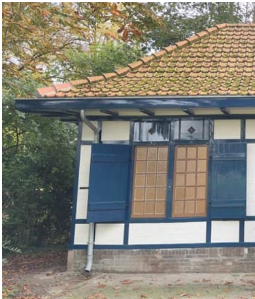
Detailfoto's van de luiken, vensters en de bimsbeton stenen als vlakvullingen (2025, Erfgoed 's-Hertogenbosch).
