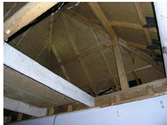
De kapconstructie, die grotendeels vernieuwd is na een brand (2015, Erfgoed 's-Hertogenbosch).
