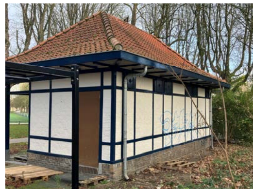
De zuidelijk georiënteerde gevel (2025, Erfgoed 's-Hertogenbosch).
